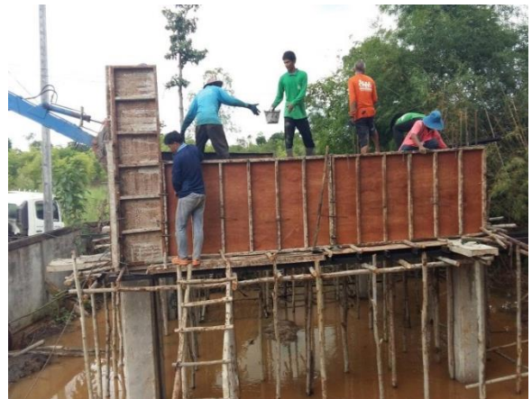
ขณะดำเนินการก่อสร้างอาคารท่อทิ้งน้ำ
