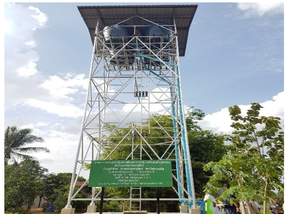
หอถังสูงภายในโรงเรียน
