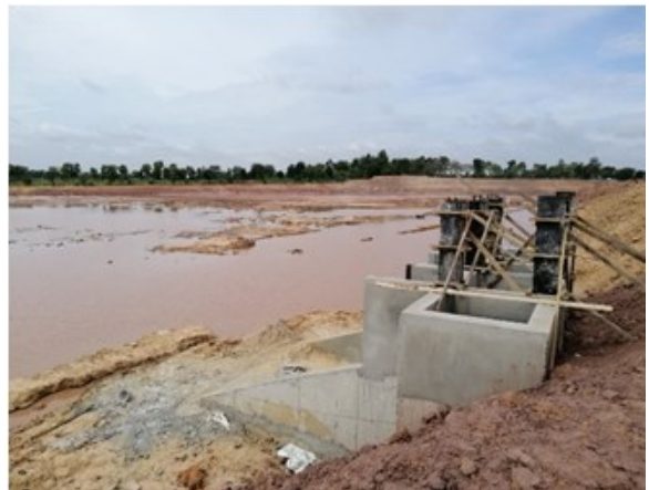
ขณะดำเนินการขุดลอก
