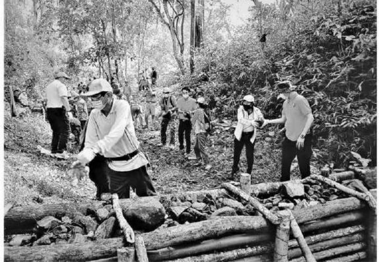
ชาวตำบลสรอยช่วยกันสร้างฝายชะลอน้ำ ในฤดูน้ำหลากฝายจะช่วยลดความรุนแรงของกระแสน้ำ และช่วยกักเก็บน้ำในหน้าแล้ง
