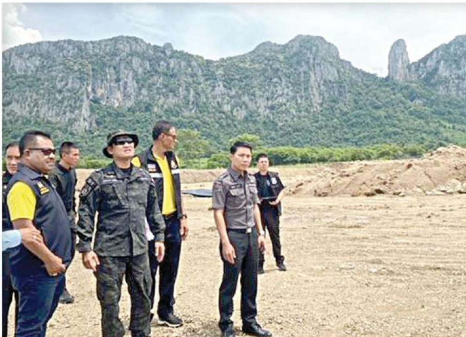
▲ ผงะน้ำท่วม...พ.ต.ต.ยุทธนา แพรดำ รองอธิบดีกรมสอบสวนคดีพิเศษ ตรวจที่ฝังกลบซากหมูเถื่อนที่ศูนย์วิจัยและพัฒนาอาหารสัตว์ อ.คลองหาด จ.สระแก้ว พบมีน้ำท่วมขังหลายหลุม จึงสั่งเลื่อนไปฝังเดือน ต.ค.
